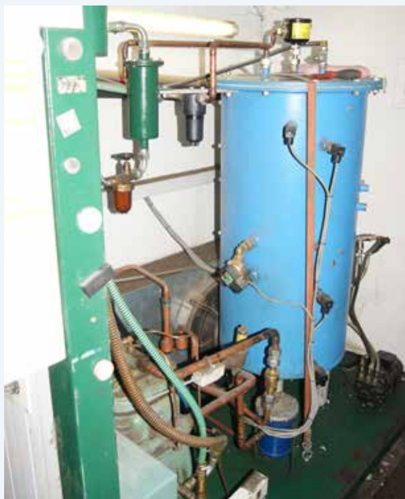
Línea de desmontaje para la extracción de refrigerantes con alicates de perforación
